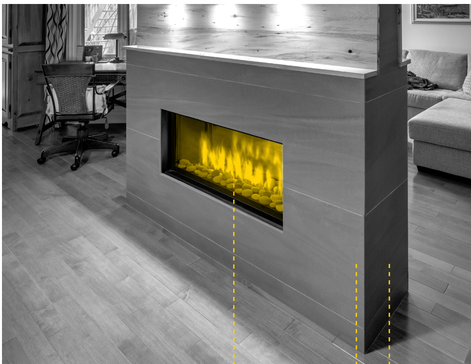
облицовка фронтальной и боковой сторон корпуса камина
